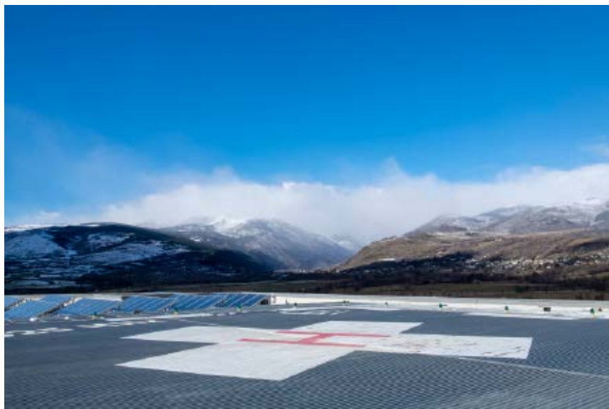
>> Pista d'aterratge de l'helicòpter d'urgències.
